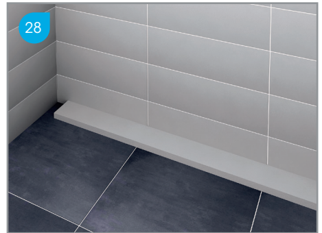
28 Vloertegels plaatsen / Fixation of the floor tiles / Poser le carrelage au sol contre le guide de pose en polystyrène / Bodenfliesen bis an das Styropor Rinnen Innenteil ankleben
